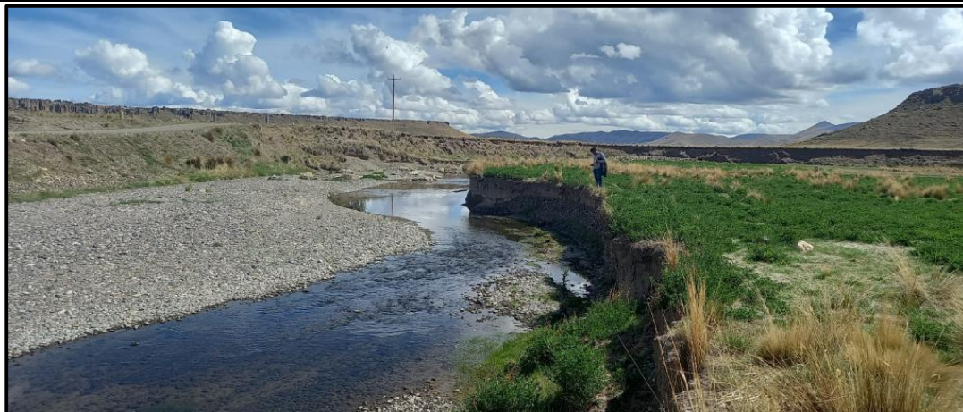
Fotografía 1. Tramo de dique margen derecho en proceso de socavación.
