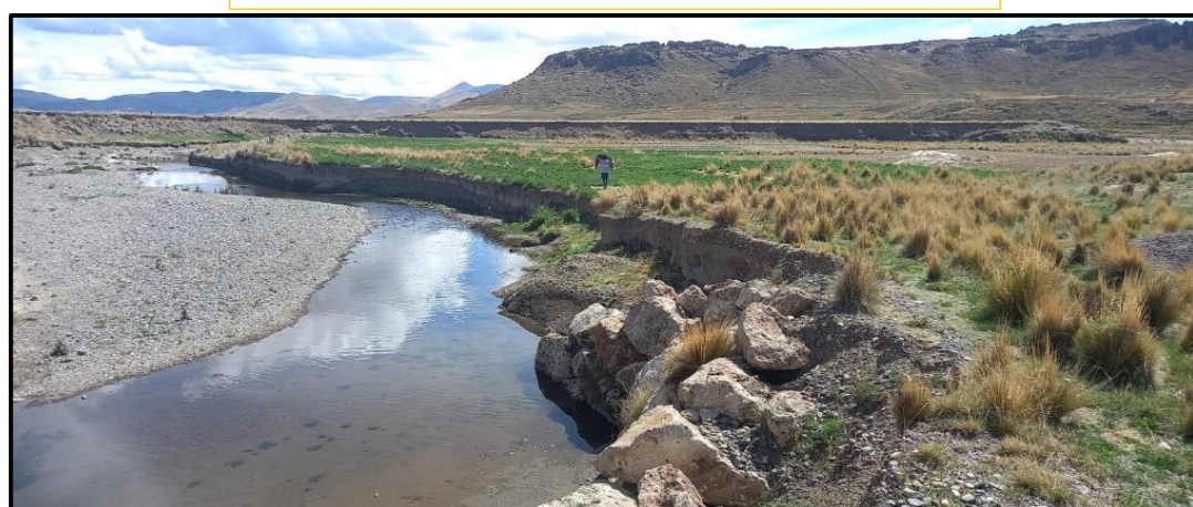
Fotografía 2. Tramo del cauce del río Imata, colmatado con material de acarreo, desviando el flujo a la margen derecho del cauce
